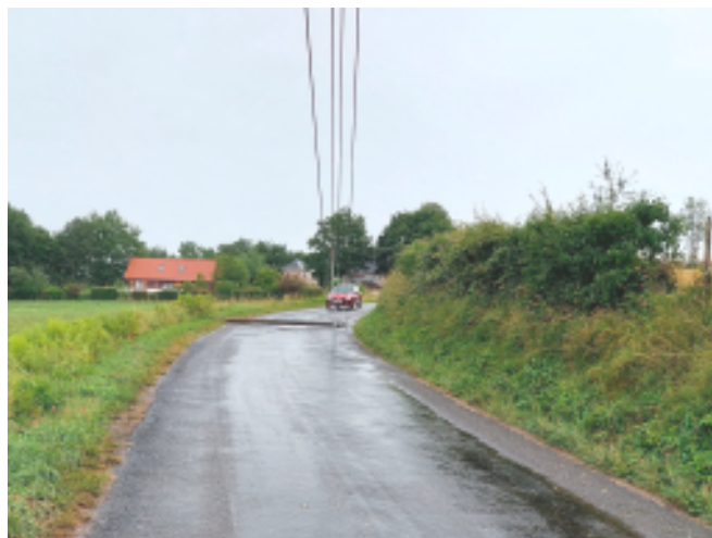
le poteau téléphonique abattu par la tempête sur la D33
